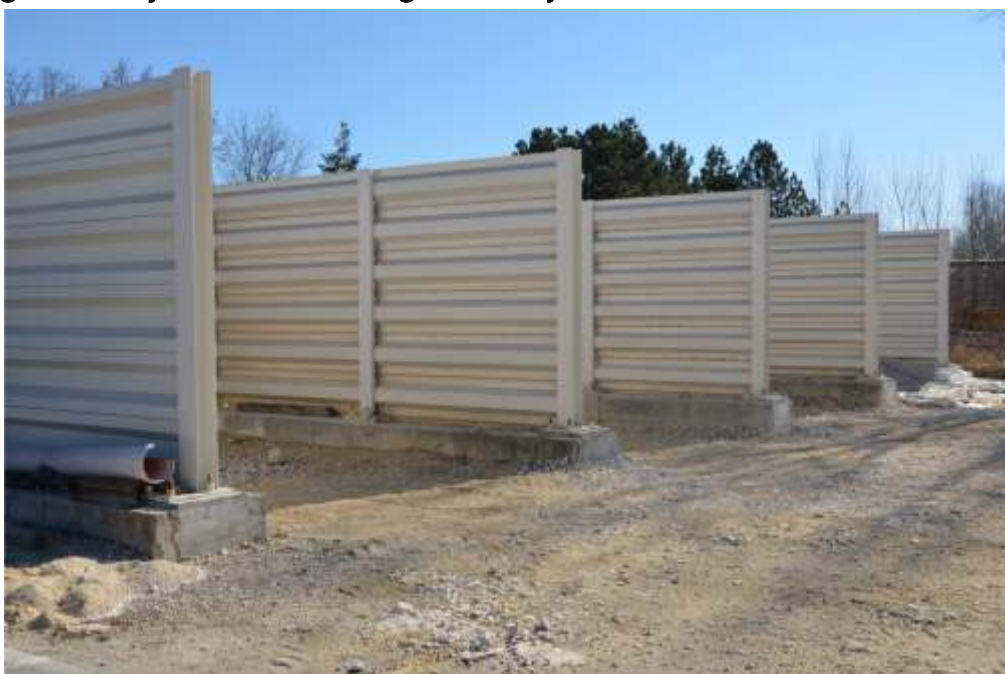
SI.6 Montažno demontažni boksovi za skladištenje ulaznih sirovina
